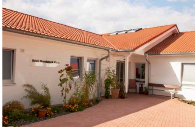
Abb. 3: Außenansicht Wohnstätte Erich Mundstock Haus (Lebenshilfe Peine-Burgdorf, 2013).
